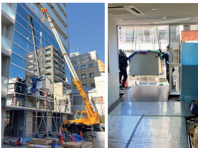
搬入作業の様子
